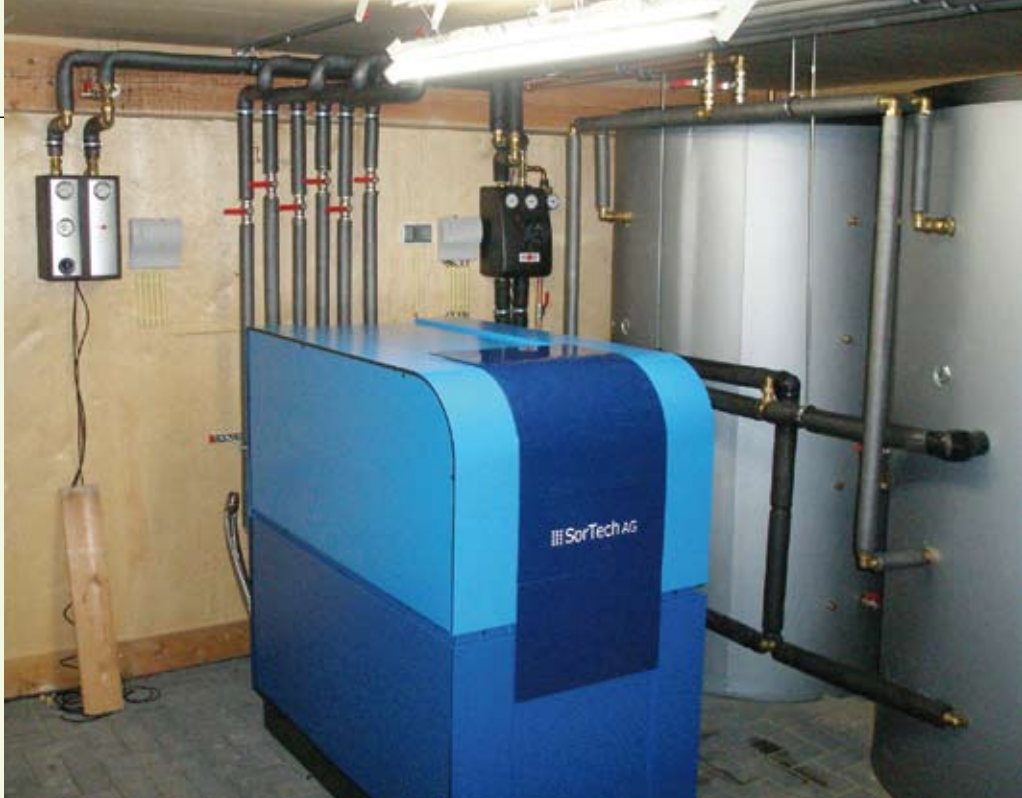
Adsorptiekoelmachine van nominaal 16 kW en twee buffervaten van elk 1,5 m 3 in Uitgeest.
