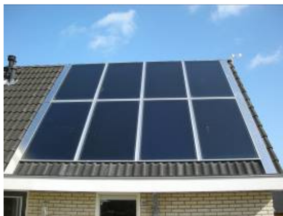
TopSon collectoren op schuin dak
