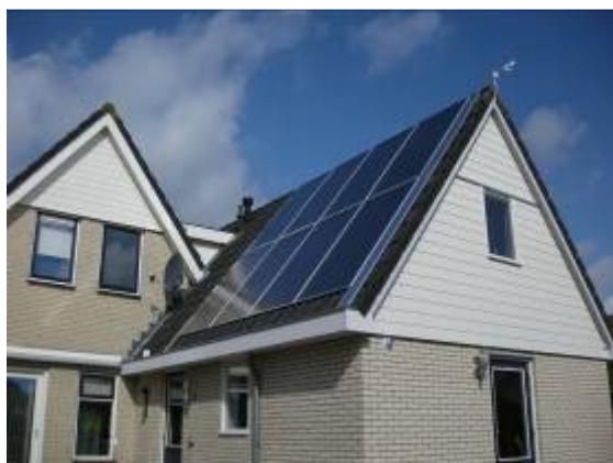
TopSon collectoren op schuin dak
