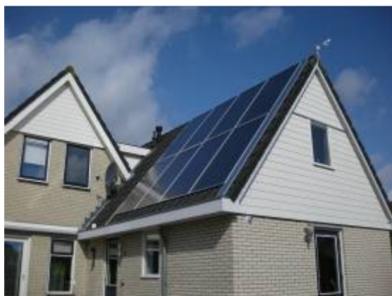
TopSon collectoren op schuin dak
